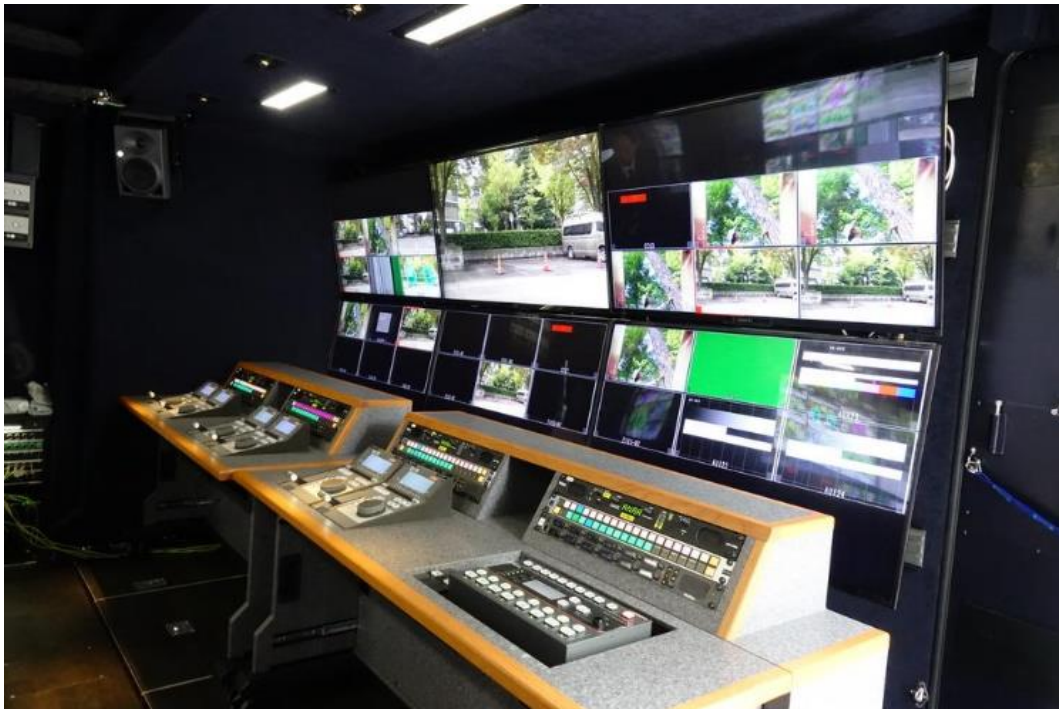
4K-OB1 中継車の内部
